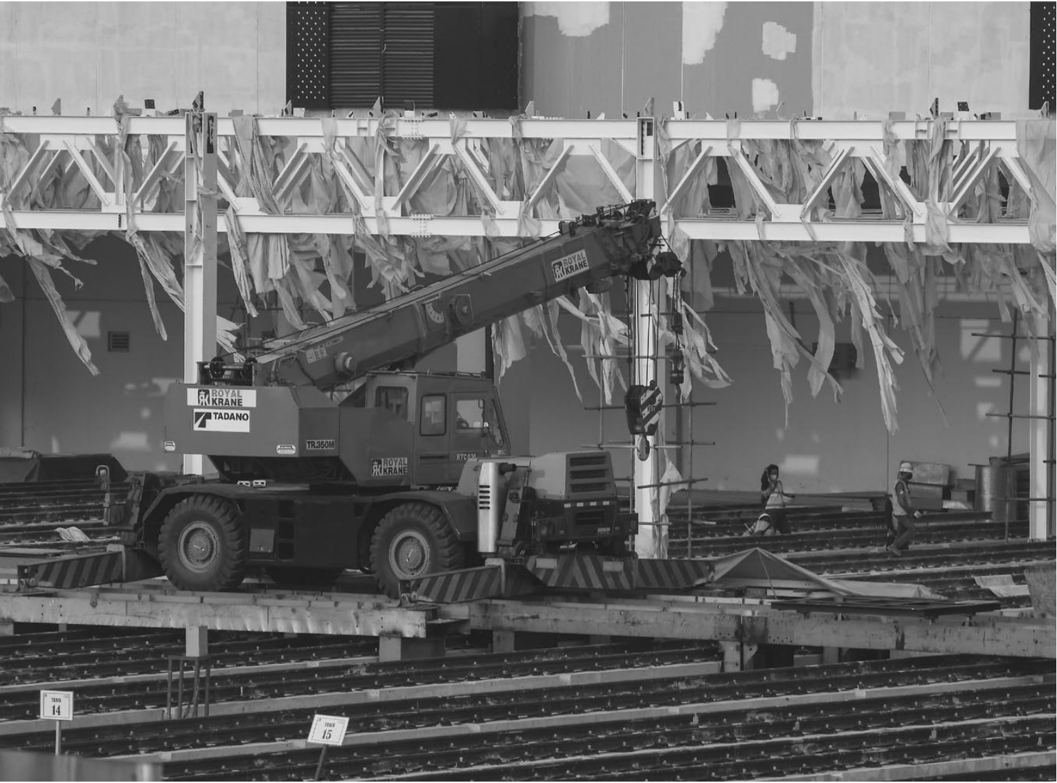
TARGET PEMBANGUNAN DEPO LRT BEKASI : Sejumlah pekerja menyelesaikan proyek infrastruktur Depo LRT (Light Rail Transit) di Jatimulya, Bekasi, Jawa Barat, Selasa (6/7/2021). Pembangunan depo yang termasuk dalam rangkaian LRT Jabodebek (Jakarta Bogor Depok dan Bekasi) itu telah mencapai 84,76 persen dan ditargetkan dapat diuji coba pada April 2022.
